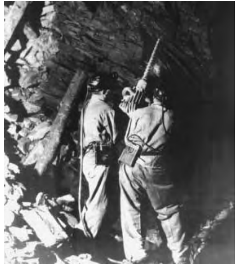
Minatori intenti alla perforazione con trivella elettrica dei fori da mina in una camera di abbattimento.
