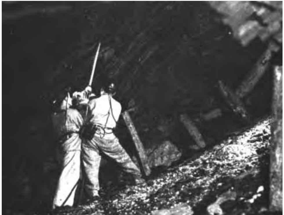
Minatori intenti alla perforazione con trivella elettrica dei fori da mina in una camera di abbattimento.
