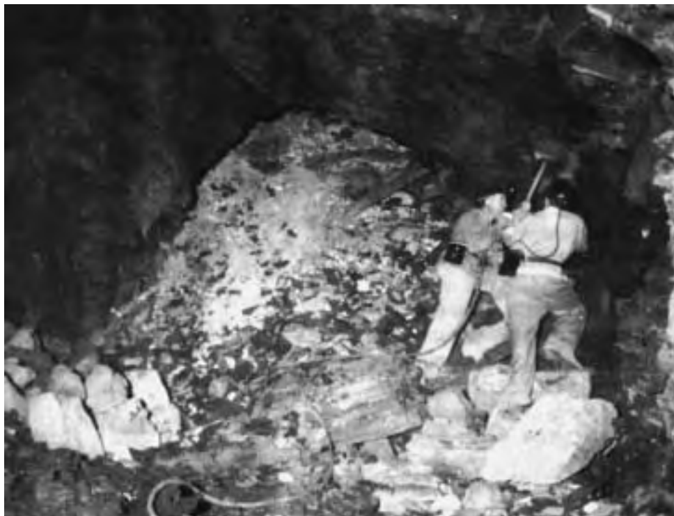
Minatori intenti alla perforazione con trivella elettrica dei fori da mina in una camera di abbattimento.
